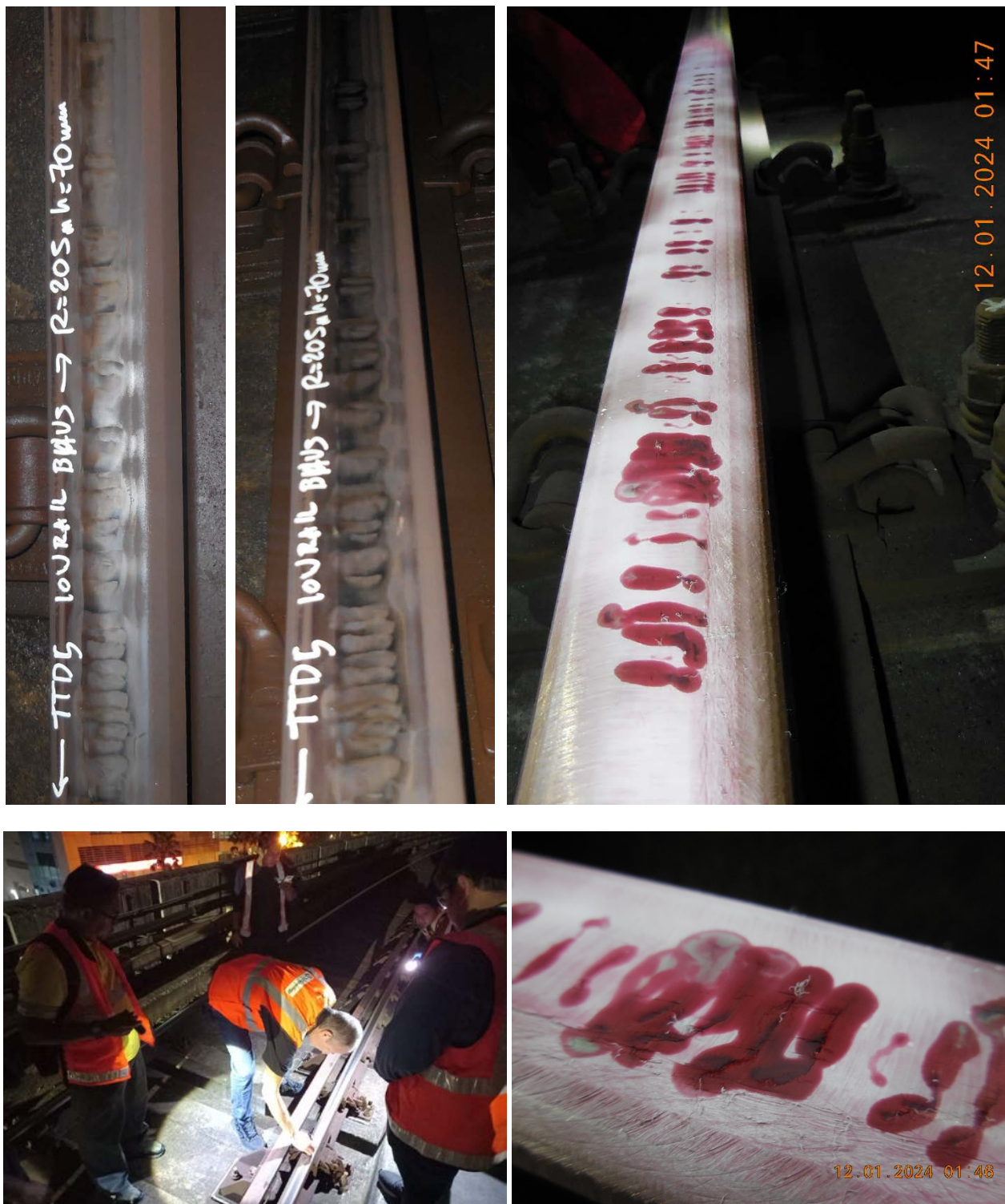
Figura 10. Il fenomeno del turtle shelling, chiaro danneggiamento da RCF (Rolling Contact Fatigue). Foto A. Bracciali ed RRT.
