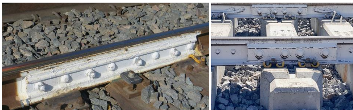
Figura 2. GII con 8 chiodi di bloccaggio (sinistra), GII supportato da una traversa speciale (destra)
